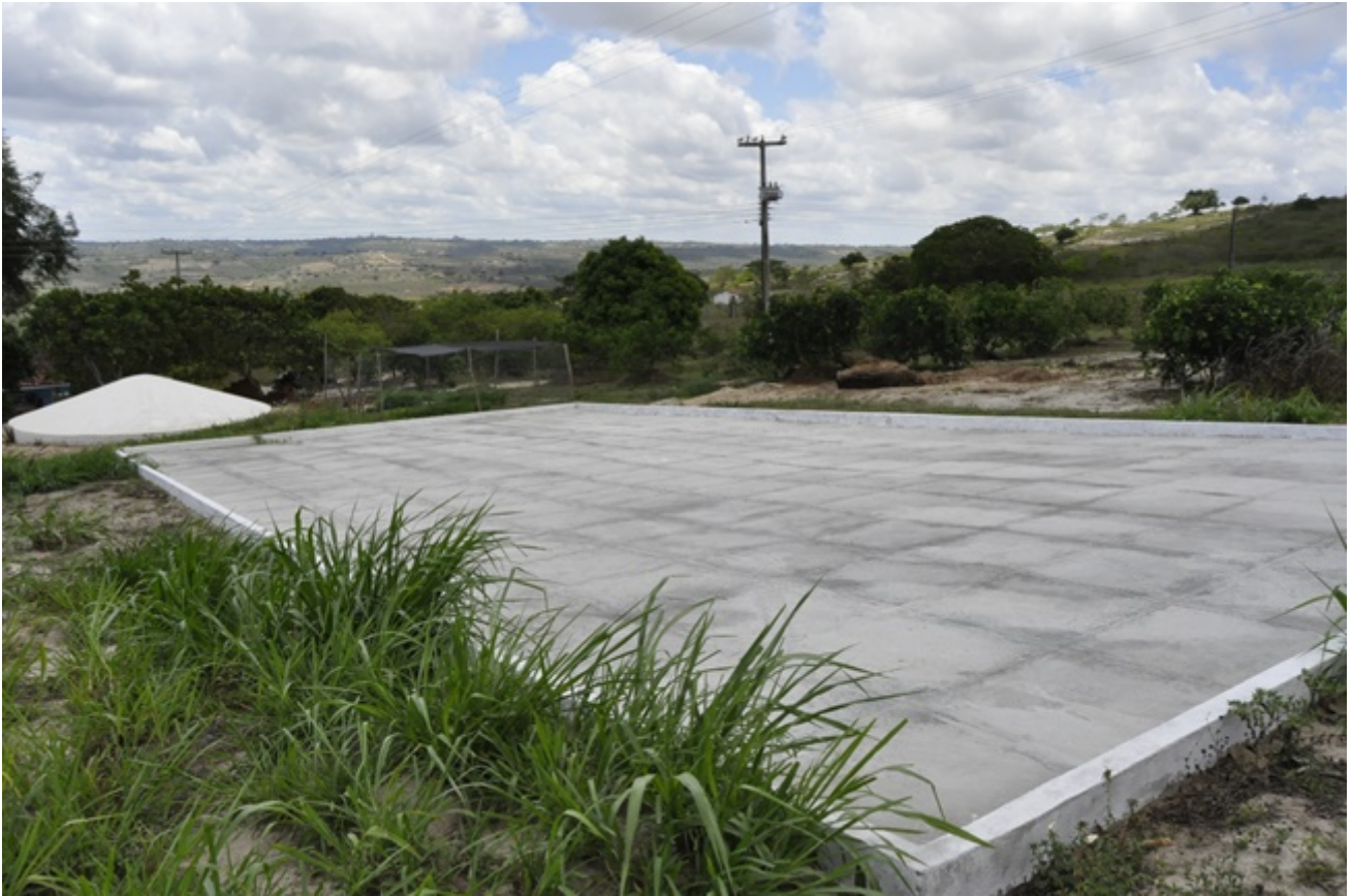
Cisterna calçada, em município do Semiárido.
