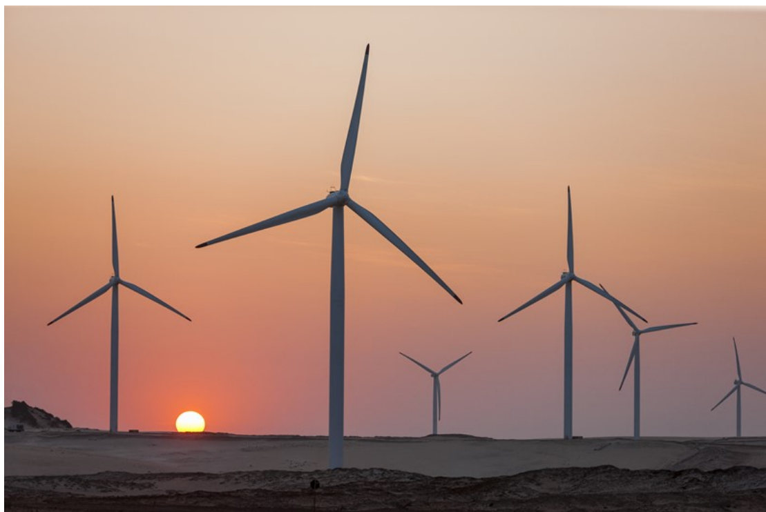
Parque eólico Bons Ventos, em São Gonçalo do Amarante (CE).
