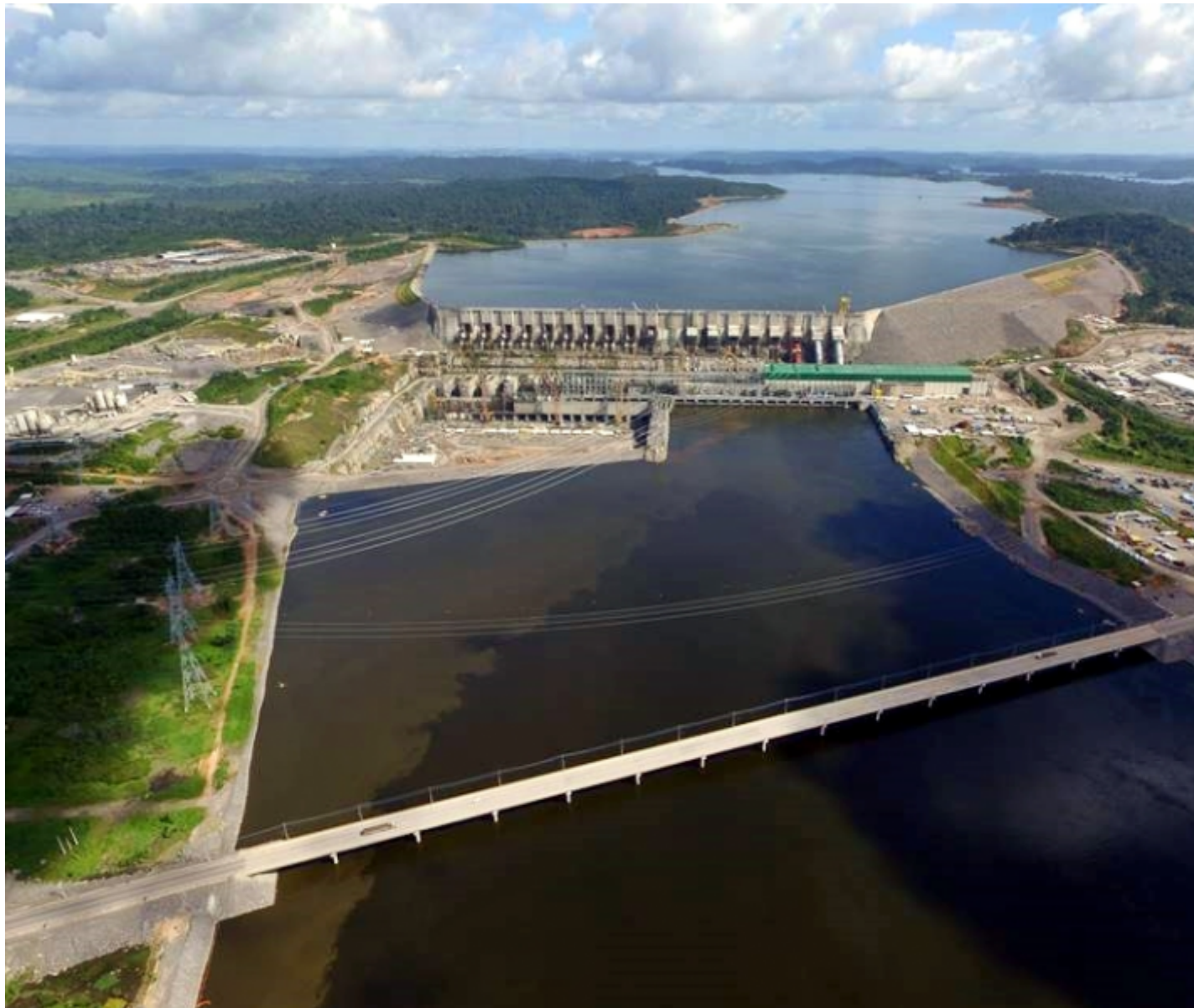
Complexo da Usina Hidrelétrica de Belo Monte.
