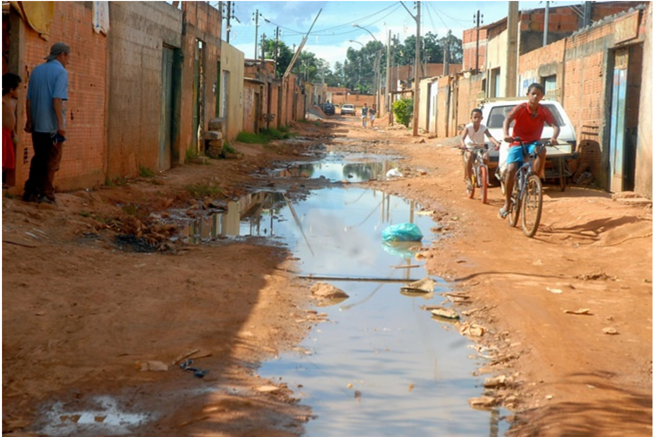
Esgotamento sanitário é o maior gargalo nas cidades. Foto: Agência Brasil.
