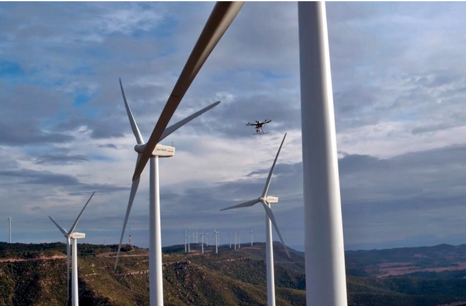
Uso de drone para inspeção de torres eólicas.
